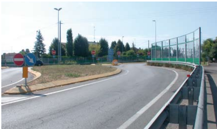
Barriere anti-rumore presso lo svincolo con la tangenziale di Decima
