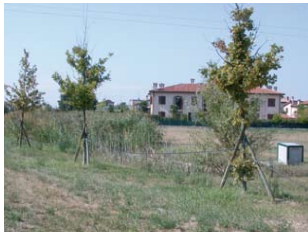
Impianto di fitodepurazione nell'area residenziale del Castagnolo
